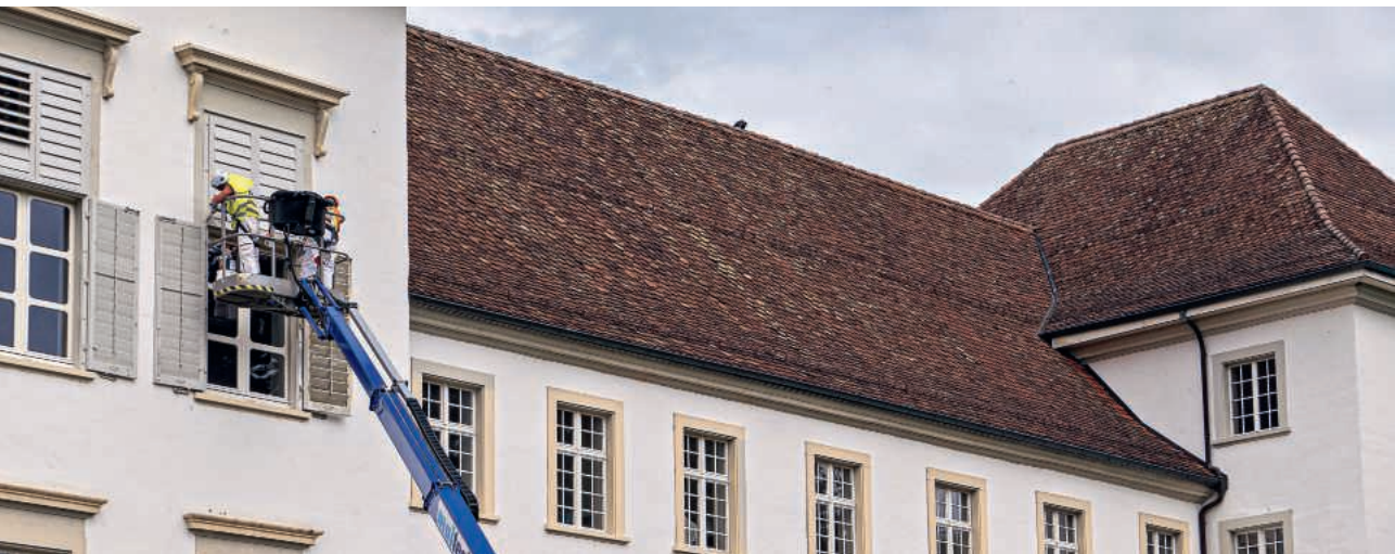
Unterhaltsarbeiten an einer Fassade des ehemaligen Klosters St. Urban.
